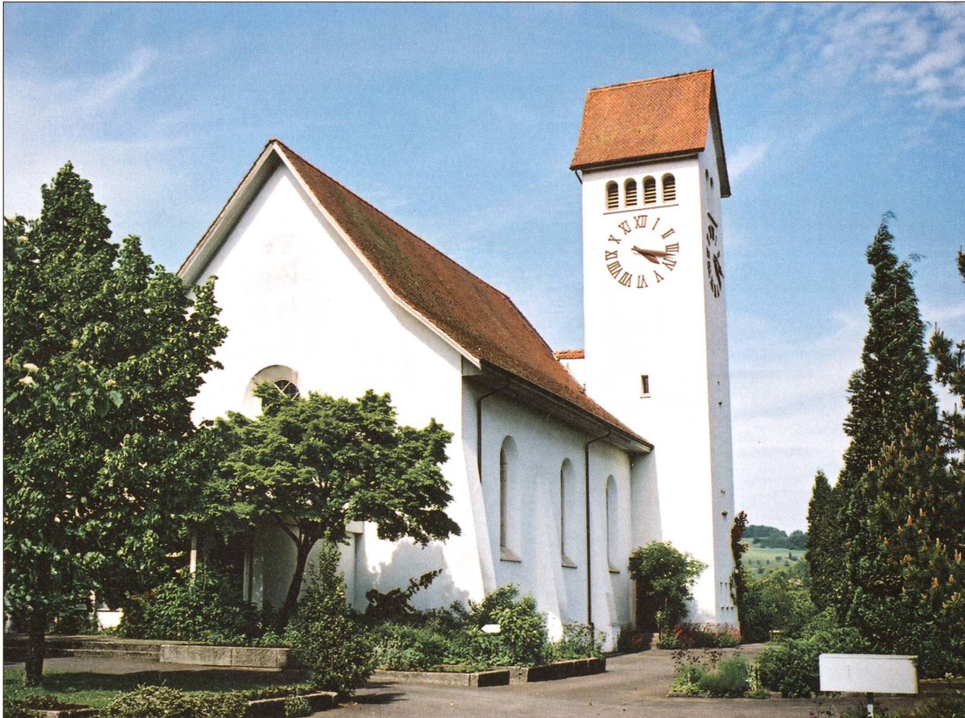
Die reformierte Kirche nach der Renovation von 1948.
