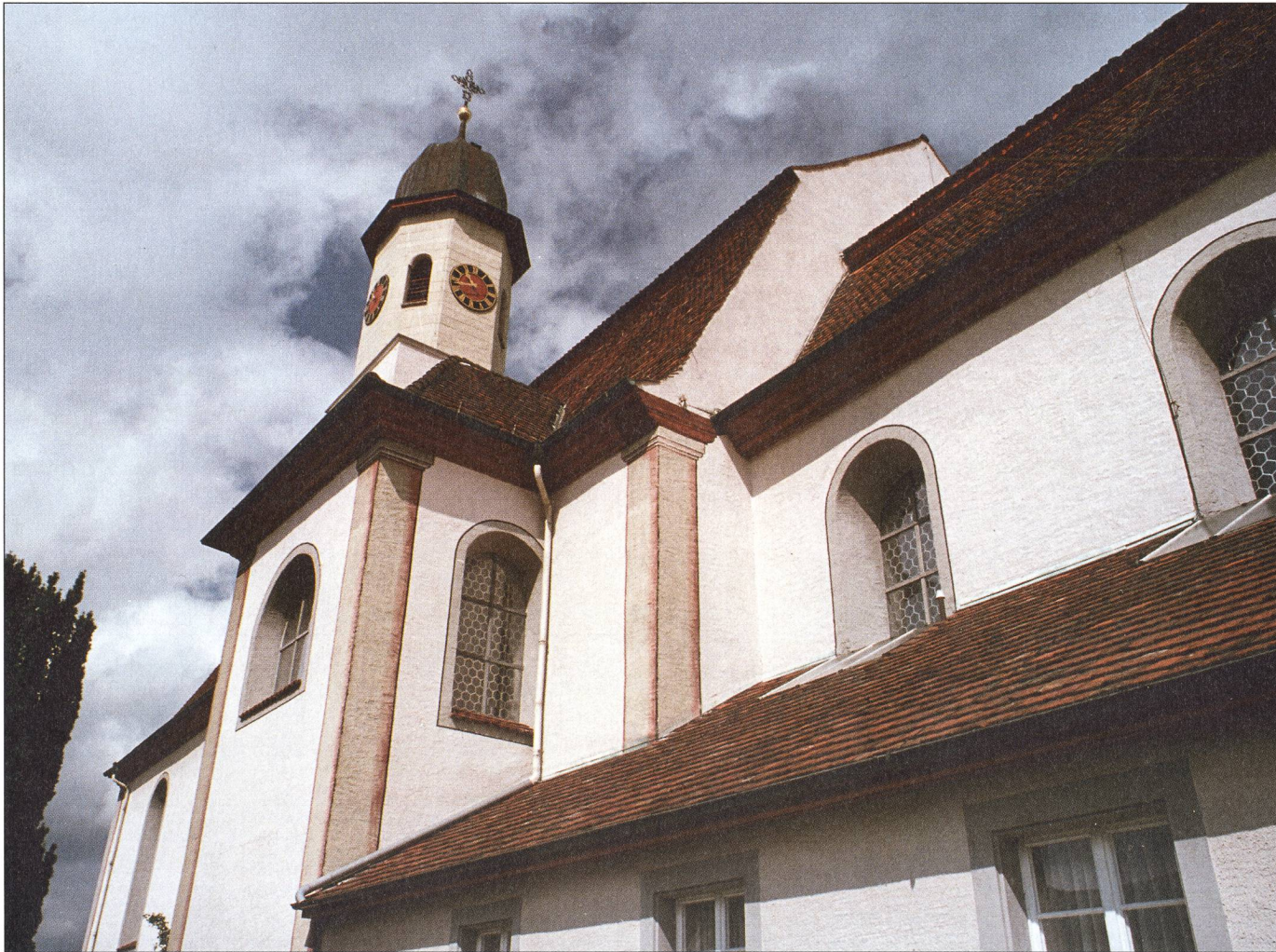
Südseite des barocken Kirchenbaus mit illusionistisch gemalten Eckpfeilern.
