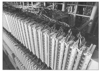
Im Kabelkeller kommen alle ankommenden und abgehenden Leitungen zusammen. Rechts im Bild die Kundenanschlusskabel, die zum Hauptverteiler im Erdgeschoss führen
