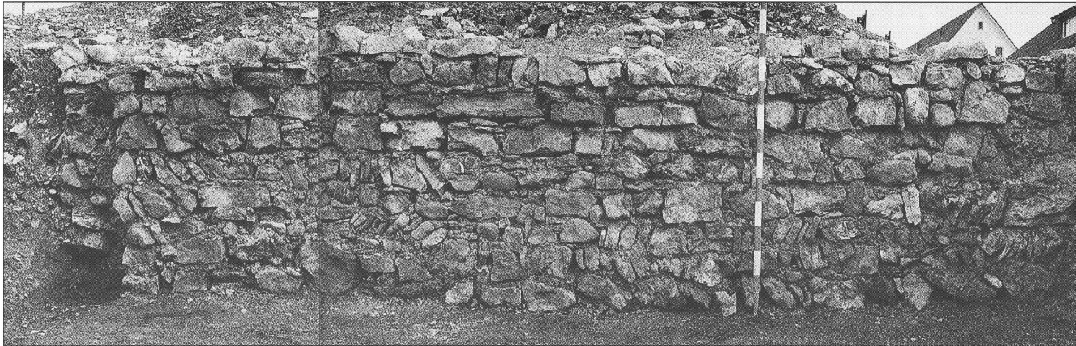
Frick, Mitteldorf 73: Bruchsteinmauer des spätmittel- alterlichen Kellers mit aussergewöhnlich unregelmässiger Mauerstruktur (z. B. teilweise Fischgrat- mauerwerk).
