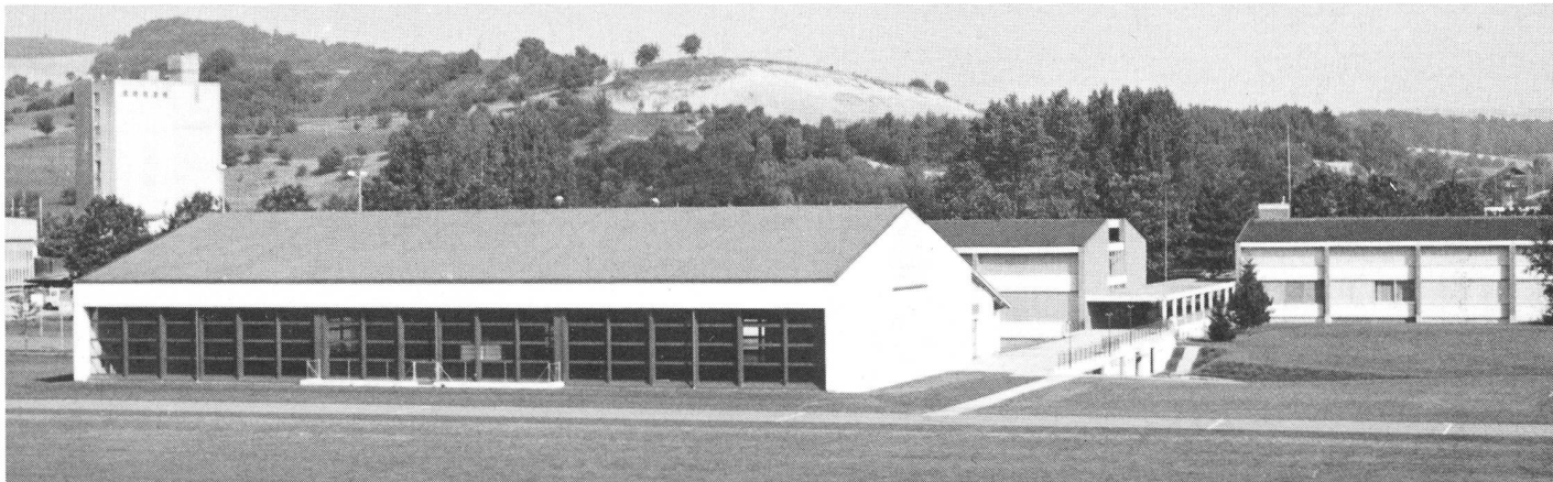
Die neue Dreifach-Sporthalle auf dem Ebnet
