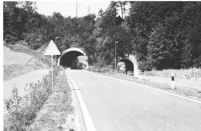
Ueker-Damm mit neuem Durchstich (links) und Radweg
