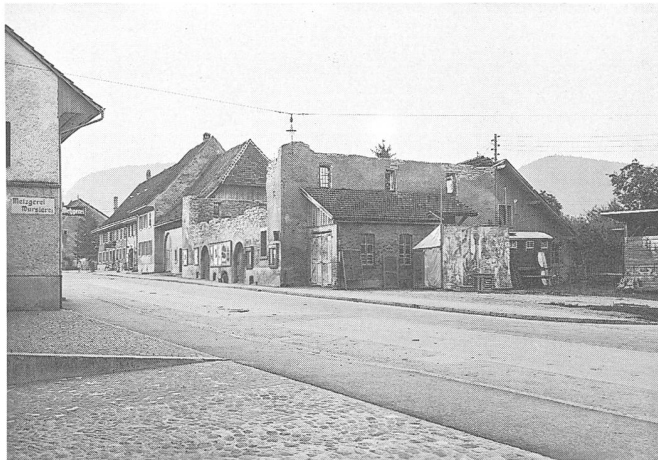
Brandruine der alten (obern) Trotte mit Anbau des Feuerwehrmagazins vor dem Gemeindehausbau 1949. Brand am 15. November 1940. Abbruch der Ruine 1946.
