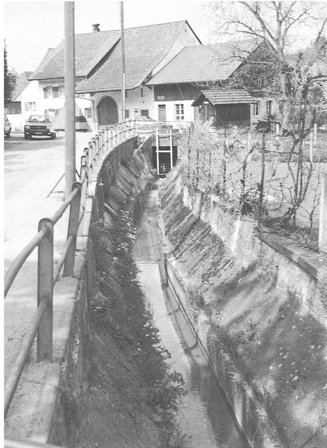
Der Feihalterbach nach der Bachkorrektion. An Stelle des Waschhauses das sogenannte «Fürwehrlüsi» bei der Liegenschaft Hayer. Seit 1980 ist auch dieser Teil des Baches eingedeckt.
