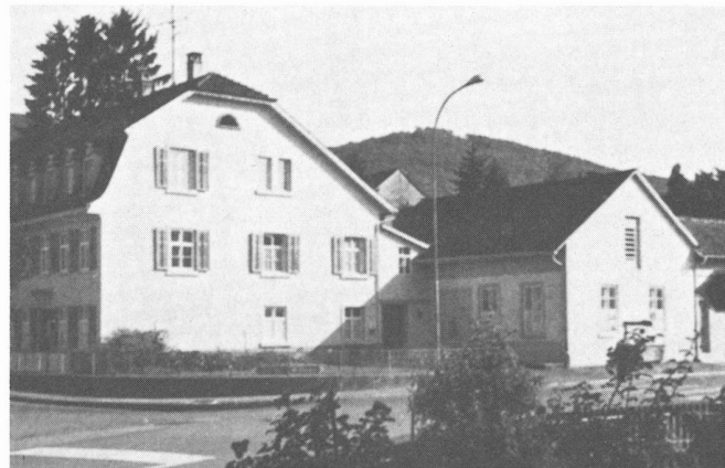
Wohnhaus ab 1888, mit dem Werkstattanbau von 1896, an der Ecke Schulstrasse/Geissgasse
