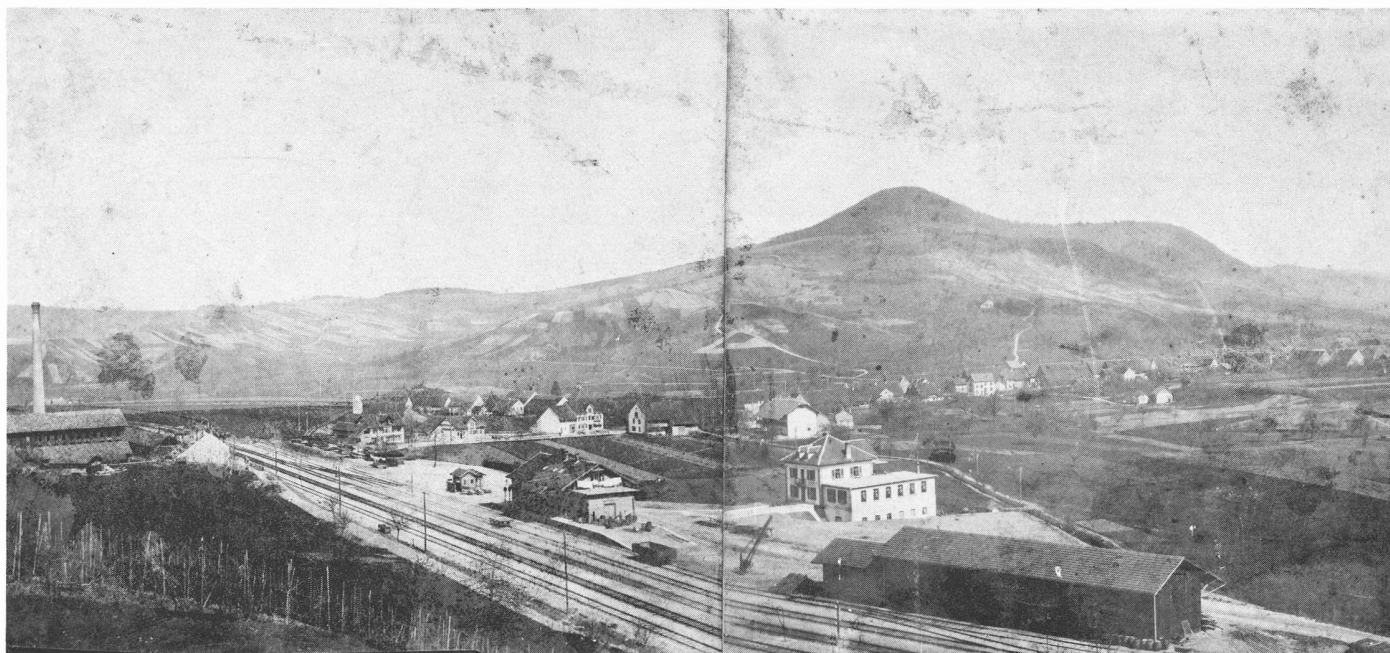
Das Bahnhofareal im Jahre 1901 mit der 1898 durch Stationsvorstand Jean Mettauer erbauten «Restauration zum Bahnhof», die ihm auch als Wohnhaus diente. Im Vordergrund rechts der Gipsschuppen.
