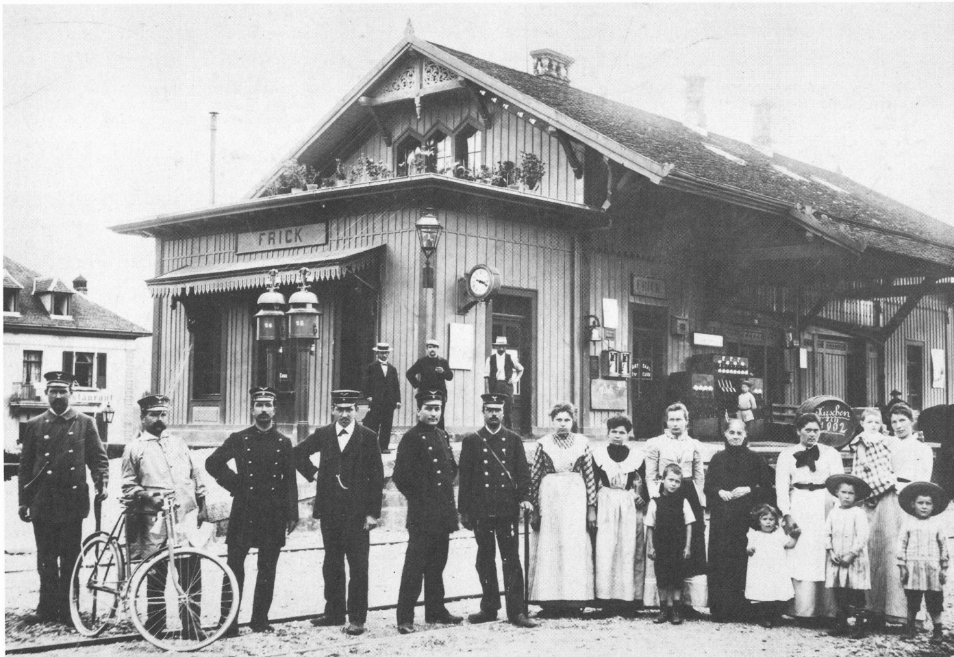
Das erste Stationsgebäude (nun Güterschuppen) im Jahre 1902
