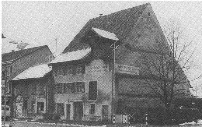
Die Bauprofile wiesen schon im Frühjahr auf den baldigen Abbruch dieser Liegenschaften hin, deren Bau bis auf 1800 zurückgeht.
