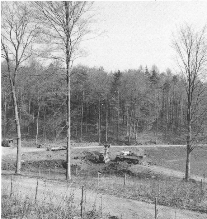
Die Aushubarbeiten begannen am 26. 4. 1984.
