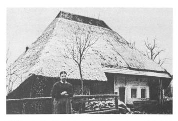
Abbildung 1 Ein «Hochstud- oder Möhlinhaus», wie es auch für Frick typisch war. (Aus «Das Schweizerhaus» Bd. V von J. Hunziker) Die Häuser fallen durch das hohe, steile und tief herabreichende Strohdach auf. Dieses wurde durch mächtige, vom Boden bis unter den Firstbaum aufsteigende «Hochstüden» (riesige Eichenbalken) getragen.
