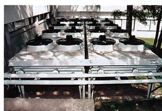
Kältemaschine mit 190 kW Leistung (links) und Aussenluftkühler mit 252 kW Kondensationsleistung über 16 drehzahlregulierte Ventilarmotoren (oben).
