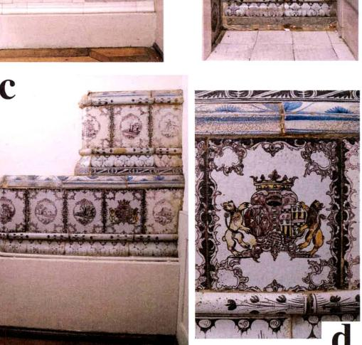
Fig. 2: Poêle blanc du XIX<sup>e</sup> siècle du salon du premier étage sur rue de la maison Grand-Rue 59 dont seuls la face côté mur, les degrés à cheval sur deux pièces, appartiennent au poêle d'origine (1747-1755). (a) Vue de front. (b) Vue sur la face et degré à cheval côté mur. (c) paroi latérale des degrés visible de la pièce voisine. (d) Catelle aux armes des commanditaires JEAN-FRANÇOIS D'AMMAN et son épouse MARIE-BARBE LANTHER. Photos SAEF, GILLES BOURGAREL.
