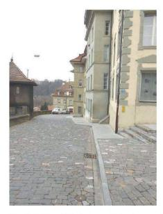
Fig. 8: la Grand-Fontaine après les travaux de 2009-2010, les ruptures de la ligne de bord du trottoir ralentissent les voitures, pavés de grès d'Alpnach. (photo P. Zwick, 2014)
