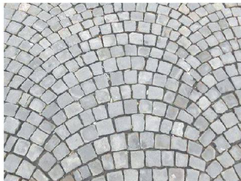
Fig. 2 : Pavage en segment d'arc, petits pavés de grès, rue de de Lausanne (photo P. Zwick, 2014)
