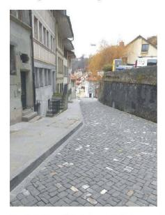
Fig. 9: la Grand-Fontaine après les travaux de 2009-2010, un trottoir de largeur suffisante est maintenu devant tous les immeubles d'habitation. (photo P. Zwick, 2014)
