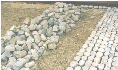
Fig. 11: Bourg de Gruyère, restauration en galets de rivière (photo P. Zwick)
