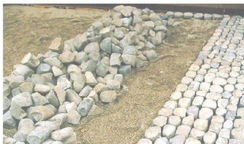
Fig. 11: Bourg de Gruyère, restauration en galets de rivière (photo P. Zwick)
