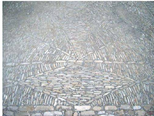
Fig. 10: Parvis de l'ancienne église d'Echarlens (photo P. Zwick, 2007)
