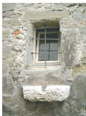
Fig. 6: Gargouille pour l'évacuation des eaux de cuisine, chemin de St-Jost (photo P. Zwick, 2003)
