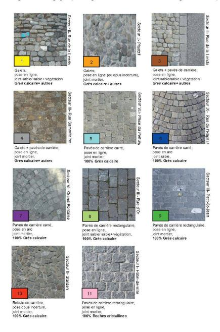
Fig. 8: Typologie des pavements en Ville de Fribourg. Dimensions des photos 1m x 1m.
