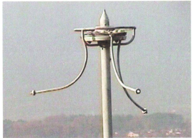
Abb. 4: Radium-Blitzableiter. Links auf einem Hochhaus in Fribourg vor der Demontage (Durchmesser der zentralen Ringes: 18 cm, Länge der Hörner: ca. 30 cm)
