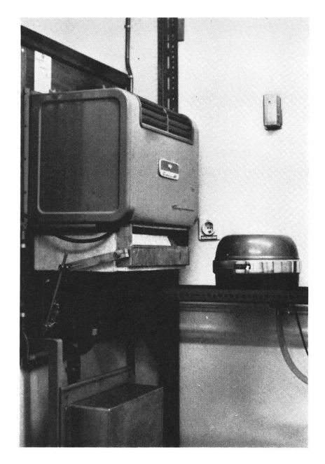
Fig. 2. Cette photo montre la partie droite des groupes A et B du schéma de principe (voir fig. 1). On reconnait l'appareil Frigidaire avec sa grille de sortie d'air — en dessous, le clapet motorisé et la commande du thermomètre à contact. A droite, on voit l'aérosol « Defensor », au-dessus de ce dernier, l'hygrostat à cheveux « Honeywell » qui le commande. Un tuyau flexible relie l'appareil Defensor à son bassin d'alimentation en eau.
