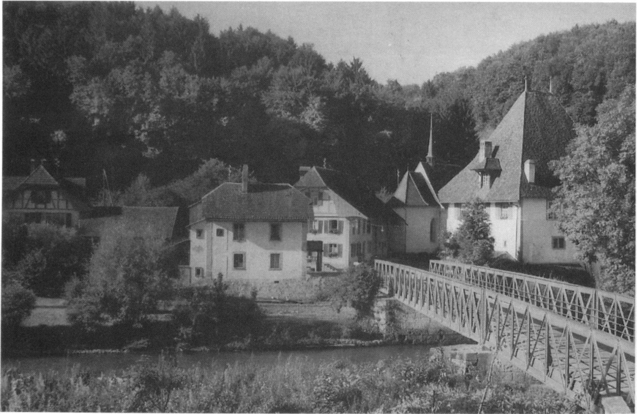
Abb. 7: Die Eisenfachwerkbrücke von 1891/1892 bei Sensebrück. Foto Josef Noth.
