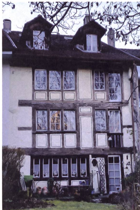
Abb. 5: Freiburg, Untere Matte 39. Rückfassade in Fachwerk mit ver- putzter Bruch- oder Kieselsteinfüllung (16. Jahrhundert?). Foto Jean-Pierre Anderegg, 2022.
