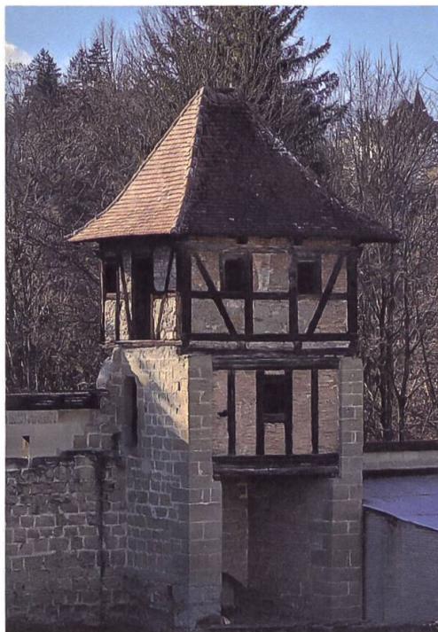
Abb. 4: Freiburg, Magerau-Tor. Zwei Obergeschosse in Fachwerk mit Backsteinfüllung (1367/1444?). Foto Jean-Pierre Anderegg, 2022.
