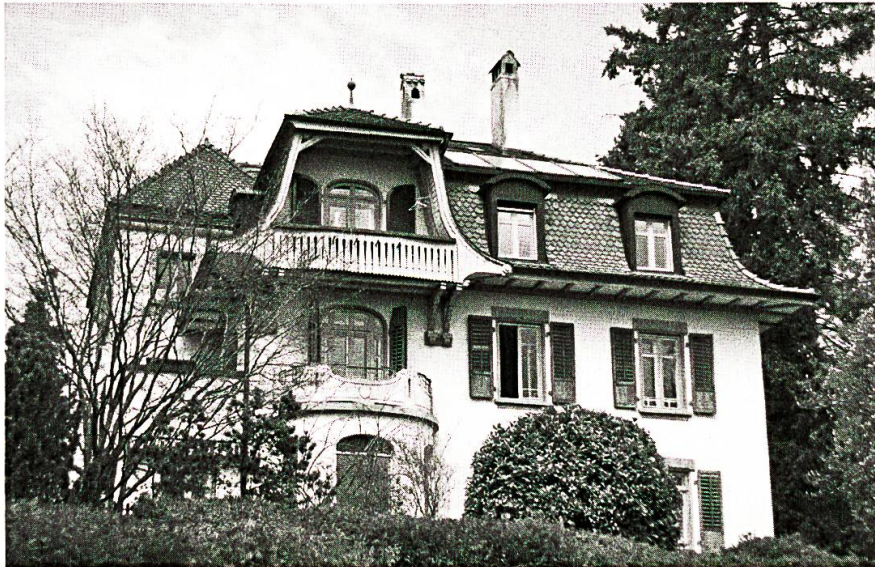
Abb. 9: Haus Avenue du Guintzet 10, 2018. Fotografie des Autors.
