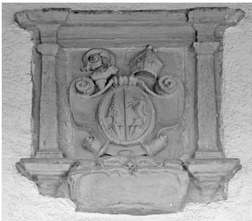
Abb. 4: Wappenrelief des Abtes de Fivaz und der Abtei Hauterive am Wirtschaftsgebäude in Grangeneuve, 1716 (Foto Ernst Tresp).
