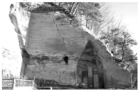
Abb. 10: Brückenkopf der alten Galtern-Hängebrücke von 1840, deren Drahtseile im Fels (oben links) verankert waren. Spitzbogennischen mit dem Lokal des ehemaligen Polizeipostens, heute ungenutzt.
