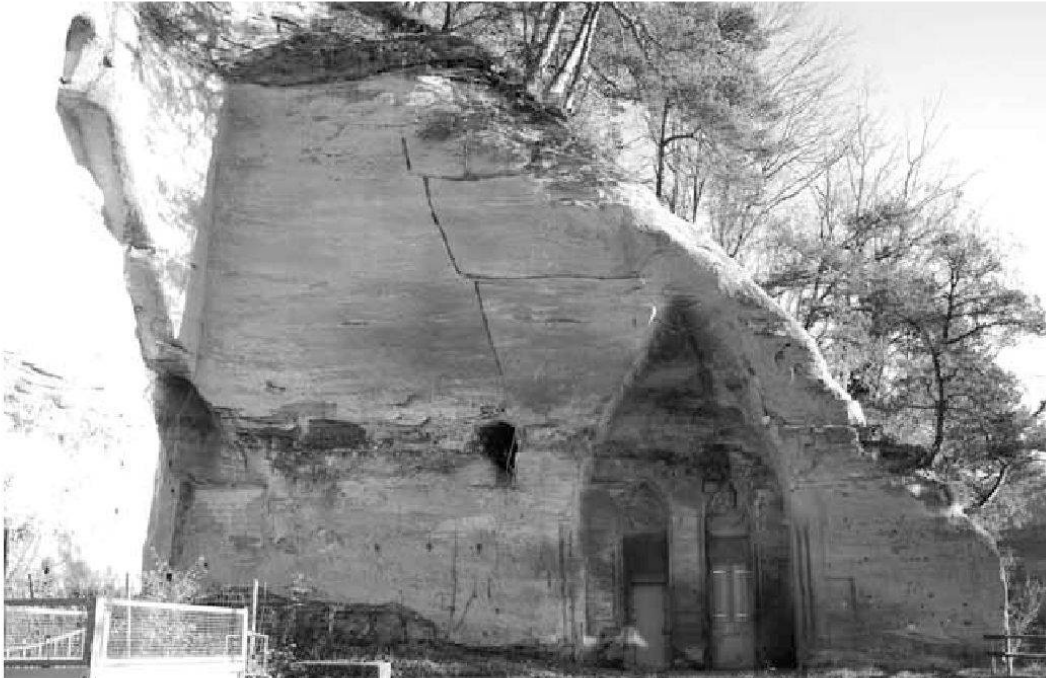
Abb. 10: Brückenkopf der alten Galtern-Hängebrücke von 1840, deren Drahtseile im Fels (oben links) verankert waren. Spitzbogennischen mit dem Lokal des ehemaligen Polizeipostens, heute ungenutzt.
