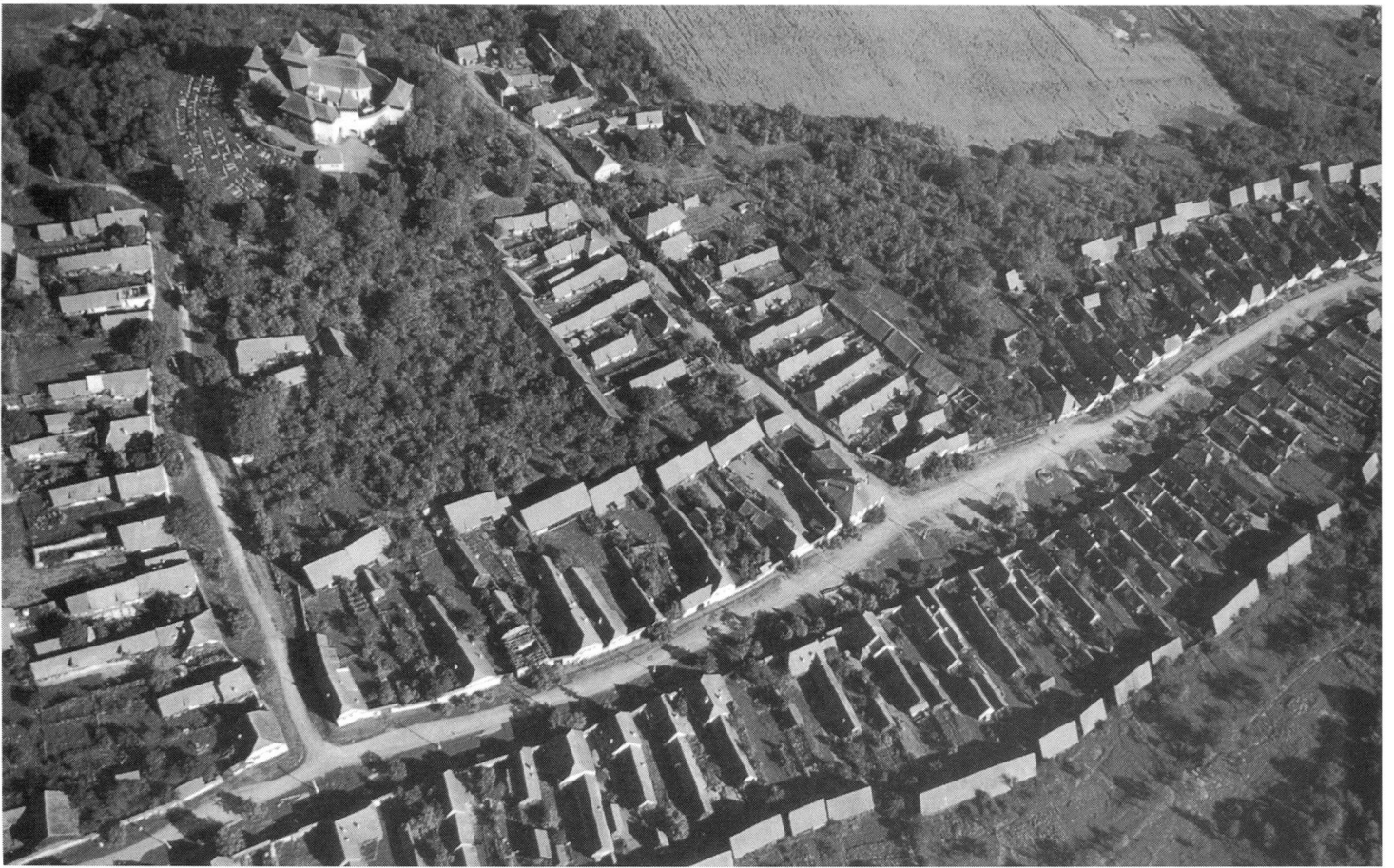
Abb. 6: Weisskirch. Luftaufnahme 1995. Eines der 240 Sachsendörfer in Siebenbürgen, nach einheitlichem Kolonisationsschema (Strassendorf mit rechtwinkliger Zeilenbebauung) errichtet. Oben links die Kirchenburg.
