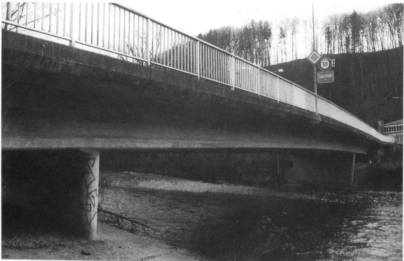
Abb. 8: Die Betonbrücke von 1968/1969 zwischen Neuenegg und Flamatt. Foto Heinrich Boschung.
