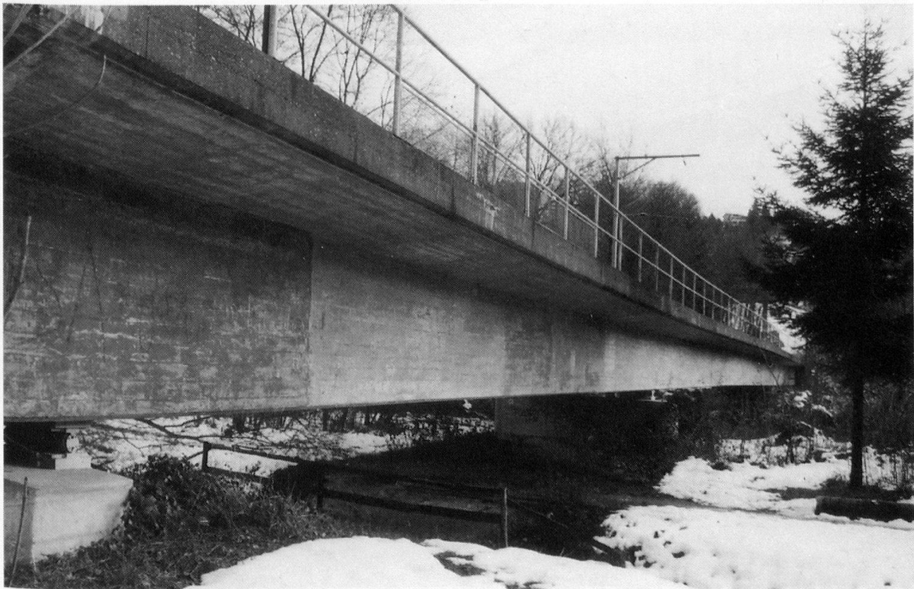
Abb. 6: Die Betonbrücke der STB von 1964 zwischen Flamatt und Neueneegg. Foto Heinrich Boschung.
