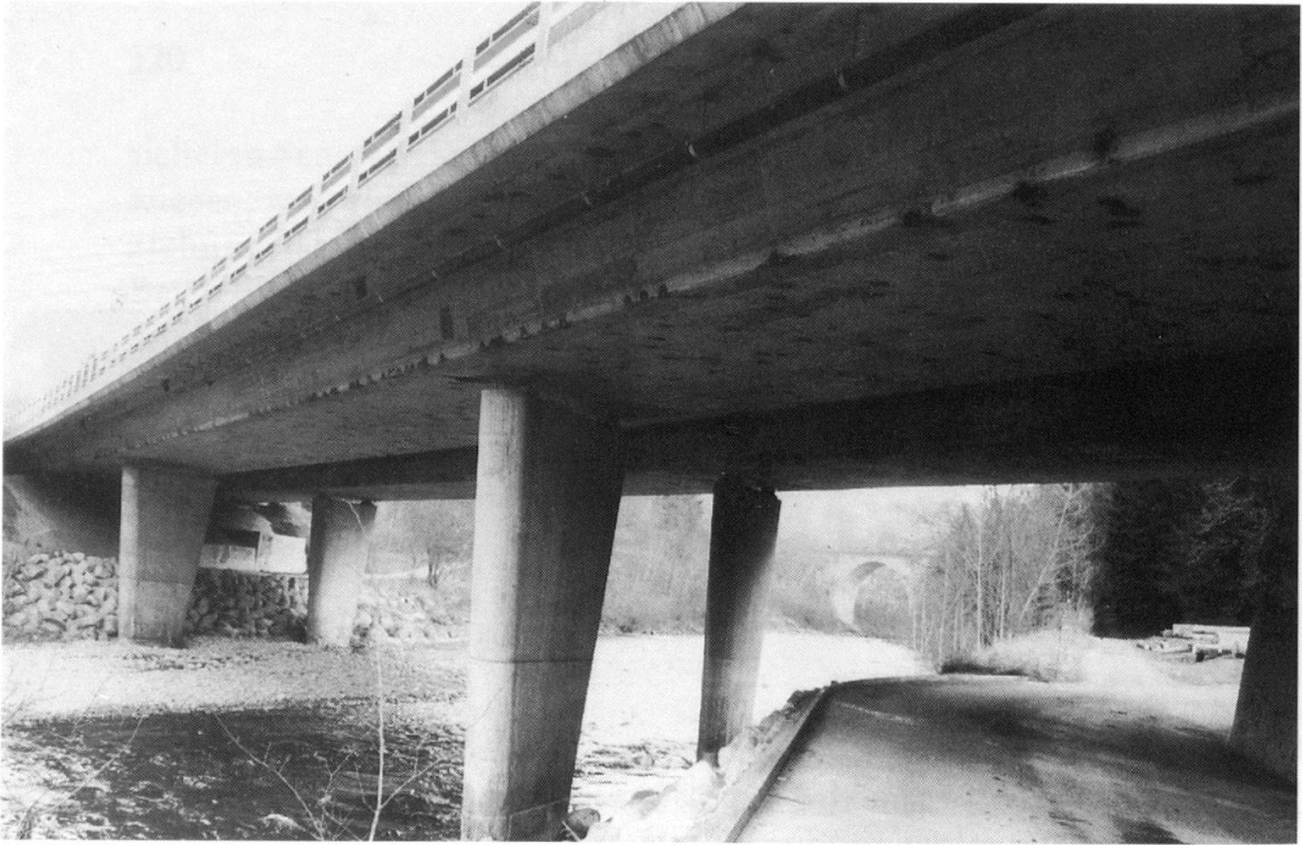
Abb. 3: Die Betonbrücke der N12 von 1971/1972 am Senseknie. Im Hintergrund Teilstück der Eisenbahnbrücke. Foto Heinrich Boschung.
