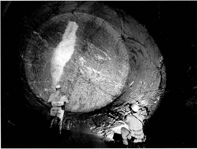
Bild 4: Ortsbrust und Schneidbild der Hartgesteinswerkzeuge (Disken). (Foto: Herrenknecht AG)
