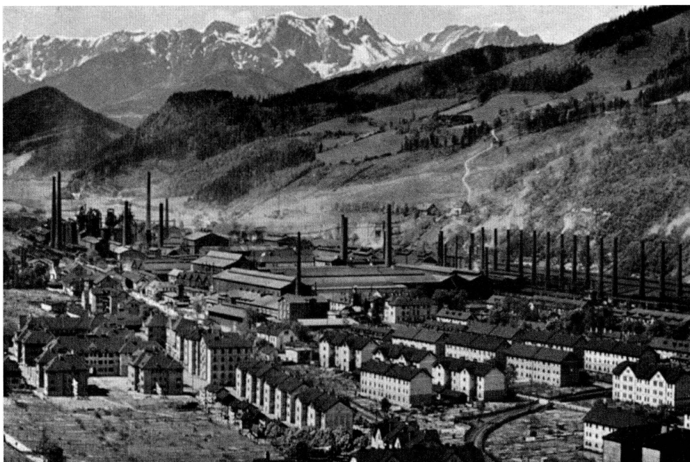
Das Werk Donawitz (Steiermark) der ÖMAG um 1930, Gesamtanlage von Süden. Die Schlotreihe rechts gehört zum Martin-Stahlwerk, in der Mitte das Feinwalzwerk, die Kraftzentrale, dahinter das Neue Blechwalzwerk, im Hintergrund links die Hochofenanlage. (aus: Kloepper, Hans; Rihel, Hans: Das steirische Eisenbuch. Graz 1937, S. 49)
