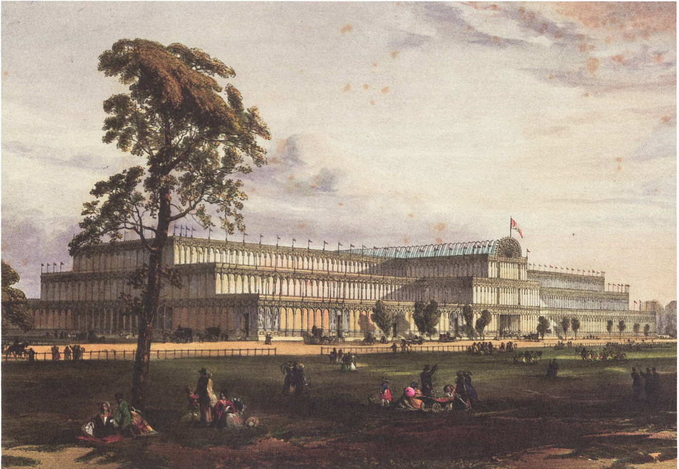
6 Der Crystal Palace, Schauplatz der Weltausstellung von 1851, war zu seiner Zeit das grösste Gebäude der Welt.
