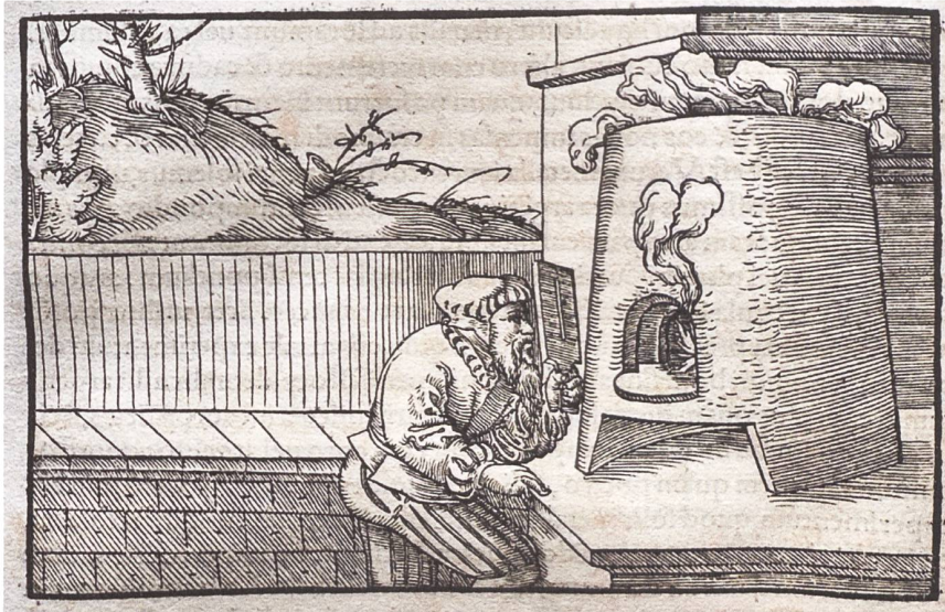
1 Eine im 16. Jahrhundert gebräuchliche Prozesskontrolle an einem Probierofen.
