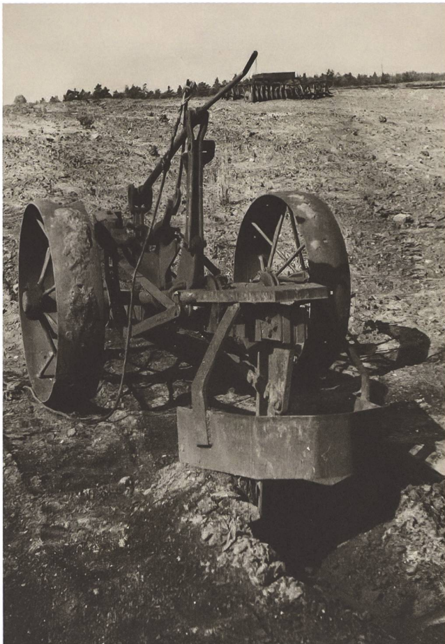
4 Der «Schälcke-Pflug» war ein Spezialgerät für die Kippenrekultivierung, 1963.
