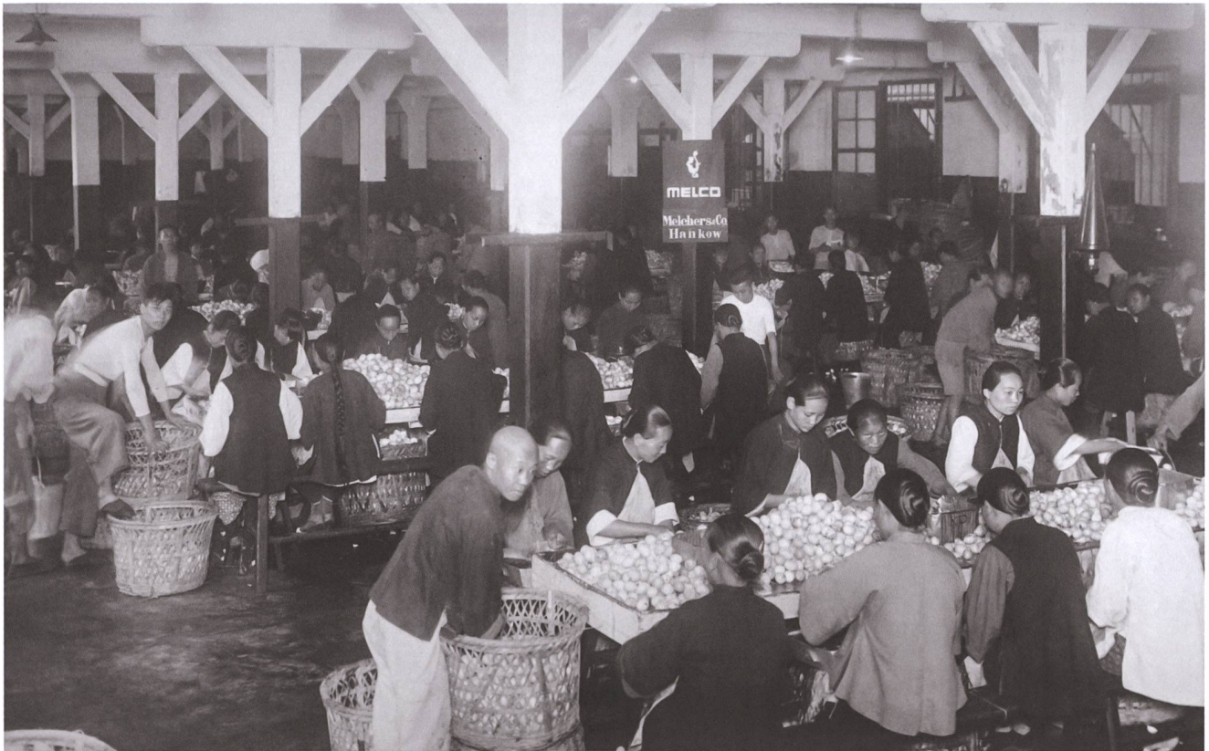
7 Aufschlagen der Eier und Trennen von Eiklar und Eigelb in der Albuminfabrik der Firma Melchers & Co. in Hankow (heute: Wuhan), um 1900.
