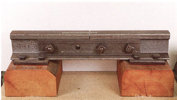
Die Gotthard-Bahngesellschaft verwendete 1874 beim Bau der Bahnlinien im Tessin noch Schienen aus Eisen. Im Bild eine Schienenverbindung zwischen zwei Schwellen (schwebender Stoss). Der Vorteil war, dass die Schienen leicht nachfedern konnten, der Nachteil, dass die Schiennägel beim Nachfedern ausrissen. (Foto: Nick Brändli, Slg. SBB Historic)
