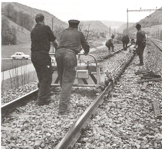
Bevor Schienen verschweisst werden konnten, mussten sie auf 25 °C aufgewärmt werden. Vorbereitung zum Schweißen 1959 in Muttensz bei Basel.
