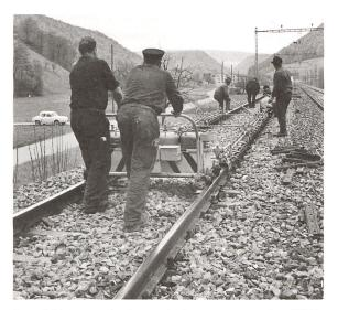
Bevor Schienen verschweisst werden konnten, mussten sie auf 25°C aufgewärmt werden. Vorbereitung zum Schweissen 1959 in Muttenz bei Basel.
