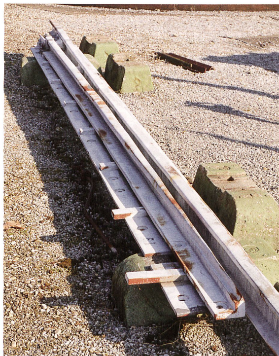
Ab 1902 setzten die SBB auf die materialintensiven und robusten Weichen mit durchgehenden Unterlagsblechen, die auch in Deutschland und in Mitteleuropa eingesetzt wurden.
