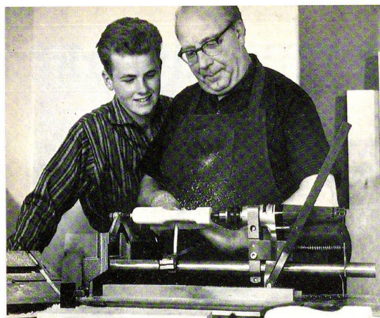
Bild 135 Längsdreheln an der Holzleibbank S 10. Anstelle des Universallinien bildet der Querhalter mit eingeschliffener Zentrierspitze den Gegenhalter.
