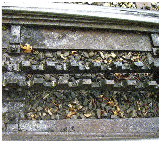
Die Spuren des von der Seite her eindringenden Zahnkranzes.
