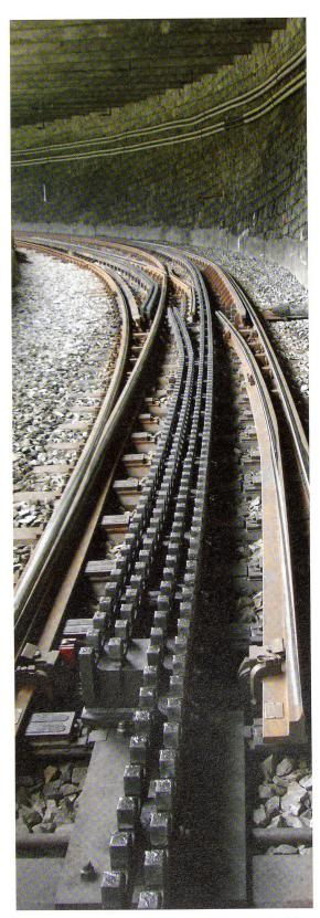
Die heute eingebauten Weichen für die Abt-Zahnstangen benötigen mehr bewegliche Zahnstangenelemente als alle andern Zahnstangensysteme.
