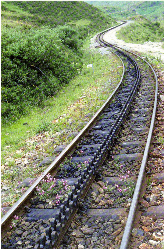
Kurvice Strecke mit zweilamelliger Abt-Zahnstange an der Furka. (Foto: Peter Berger)
