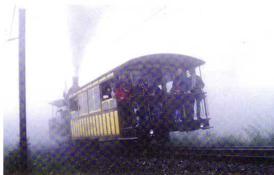
Die Rigibahn-Lokomotive Nr. 7 von 1873 kurz vor Erreichen der Station Rigi Kulm. Dies war die erste von der SLM Winterthur, allerdings nach Zeichnungen von Niklaus Riggenbach gebaute Lokomotive. (Foto: Peter Berger)
