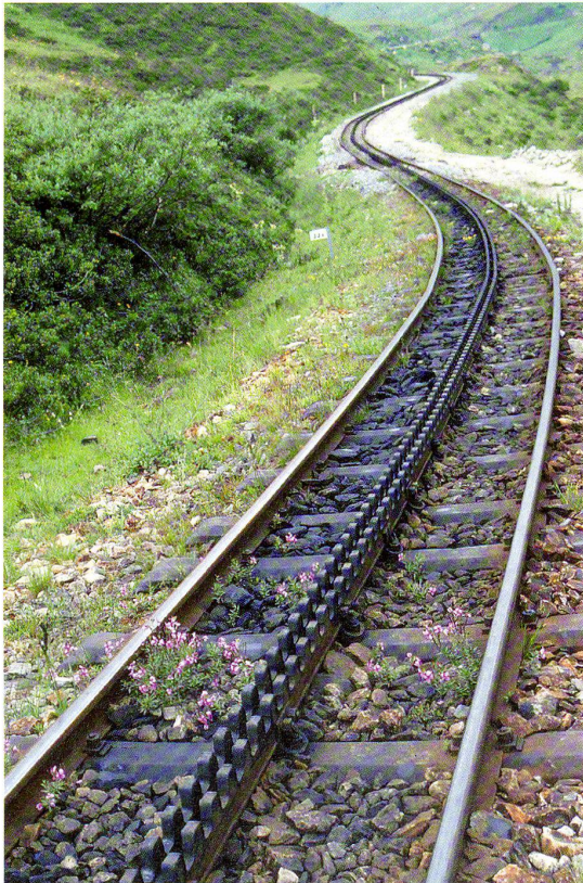
Kurvige Strecke mit zweilamelliger Abt-Zahnstange an der Furka. (Foto: Peter Berger)
