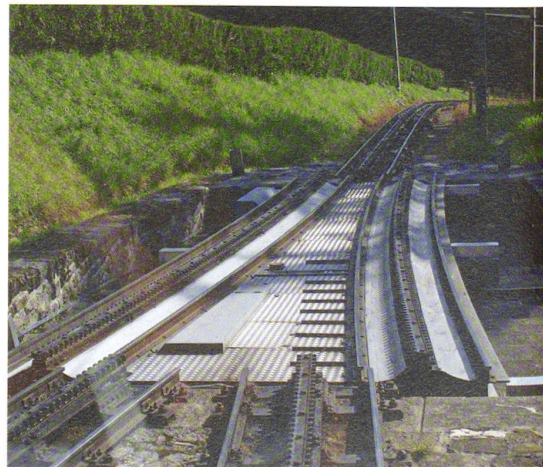
Heute noch betriebene Anlage der Pilatusbahn. Je nachdem, welcher Strang der Ausweichstelle benützt werden muss, wird das passende Gleisstück eingefahren.
