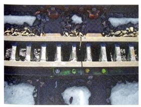
Die Auswirkungen einer sich verändernden Stosslücke sind gut erkennbar. Typisch sind die stärkere Abnützung der Zähne neben dem Stoss und der Verschleiss an der falschen (der talseitigen) Zahnflanke.
