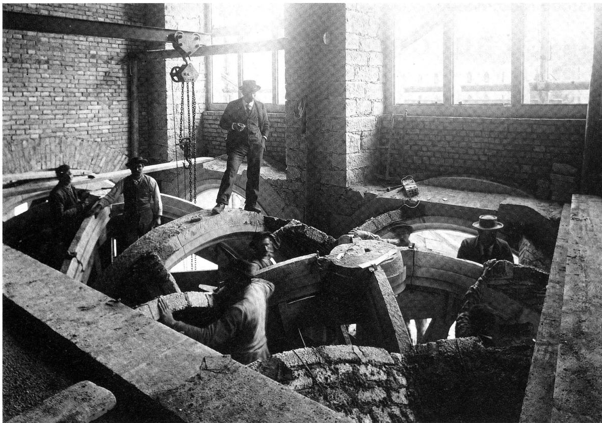
Baustelle des Stadthauses Fraumünsteramt, Zürich, Foto 1899.
