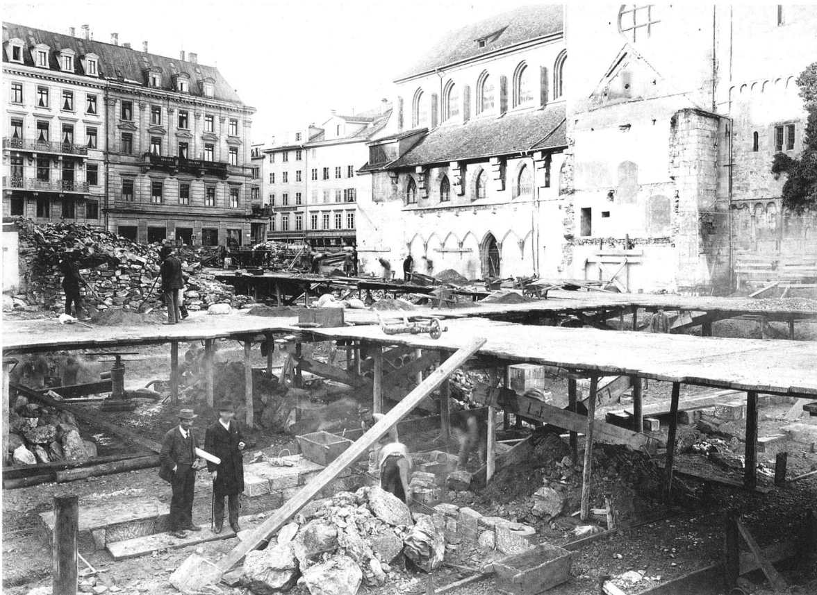
Baustelle des Stadthauses Fraumünsteramt, Zürich, Foto 1899.
