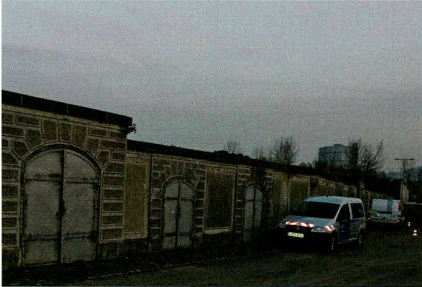
Überdeckte Langsamfilter von 1905.
