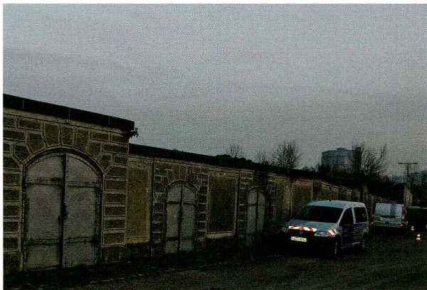
Überdeckte Langsamfilter von 1905.
