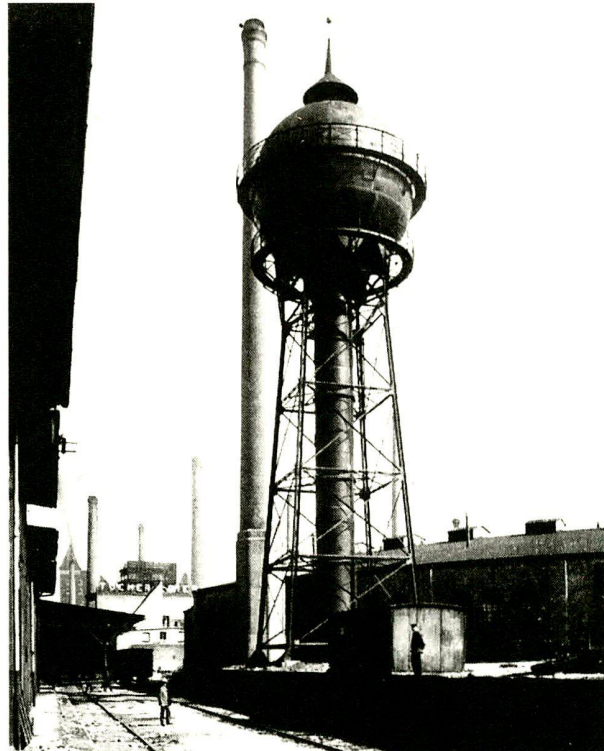
Der Wasserturm Bauart Klönne mit kugelförmigem Behälter von 1907 am Bahnbetriebswerk Berlin Anhalter Bahnhof wird heute noch als Löschwasserspeicher des Technikmuseums genutzt.
