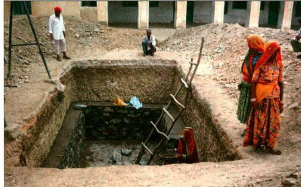
Sikkim (2005): Der Bau von Regenwasserauffangbecken bildet einen der Schwerpunkte von «Clean Water». Projektpartner: Barefoot College (Indien).
