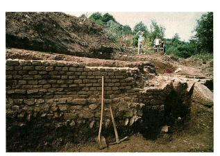
Kleine Aquäduktbrücke der Eifelwasserleitung bei Mechernich-Vollem. Da der Bau der Aquäduktbrücken zeitlich vorgezogen wurde, stellten sie immer Problemstellen dar; sie mussten von der nachgeführten Wasserleitung möglichst höhennah getroffen werden.
