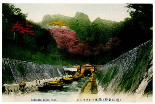
Bild 13: Wasserzuführung zum Kraftwerk Keage in Kyōto: Tunneleingang des Kanals auf der Seite des Biwa-Sees; Entwurf und Bau von Tanabe Sakurō, Absolvent des College of Engineering, fertiggestellt 1890. (Postkarte, Beginn des 20. Jh.)
