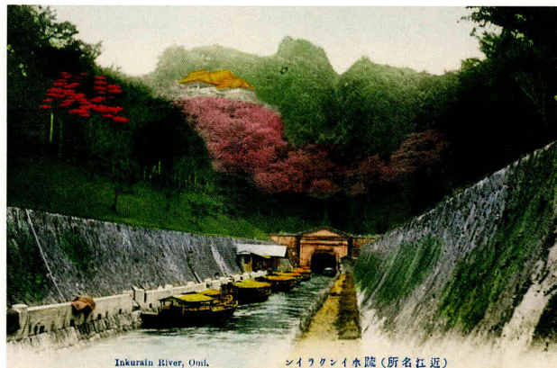
Bild 13: Wasserzuführung zum Kraftwerk Keage in Kyōto: Tunnelleingang des Kanals auf der Seite des Biwa-Sees; Entwurf und Bau von Tanabe Sakurō, Absolvent des College of Engineering, fertiggestellt 1890. (Postkarte, Beginn des 20. Jh.)
