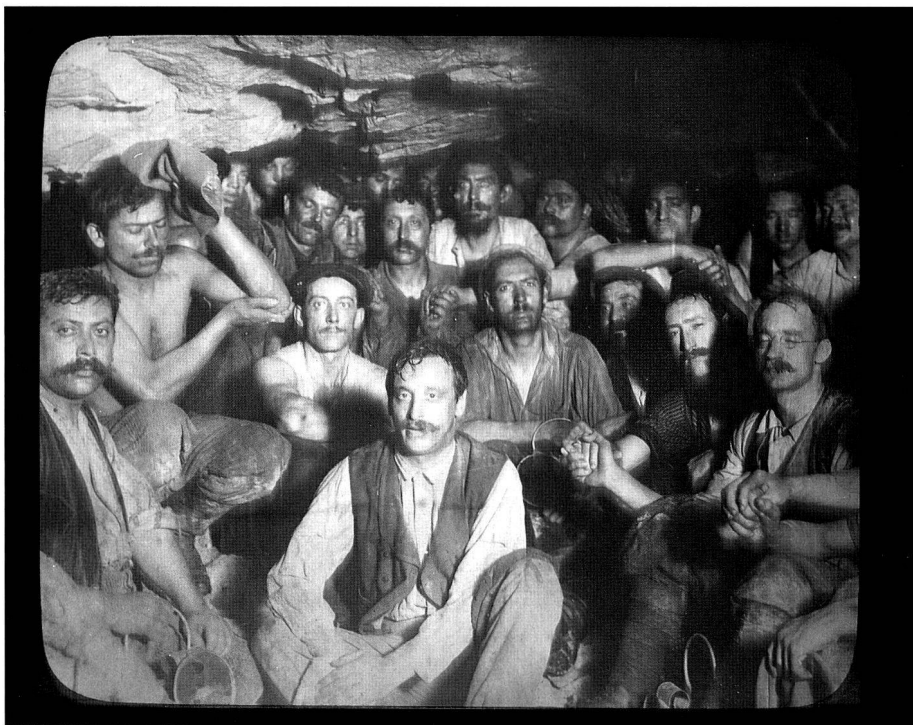
Bild 3: Wehrli, Leo: Lötschberg-Durchschlag, Mannschaft mit Ingenieur Casparis, 1911. (Foto: ETH-Bibliothek, Bildarchiv, Dia 247: 2040b)
