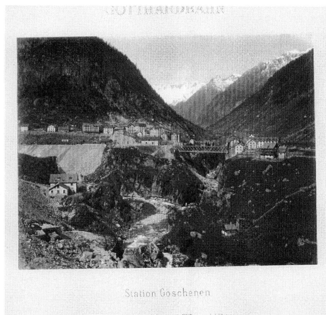
Bild 9: Göschenen während der Bauzeit. (Foto: Zentralbibliothek Zürich)
