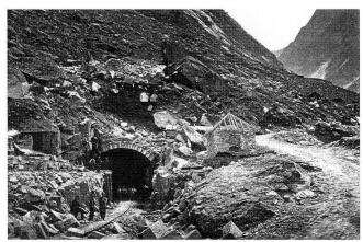
Bild 6: Baubeginn in Göschenen. (Foto: Adolphe Braun/Kurt Zurfluh: Gotthard. Als die Bahn gebaut wurde. Zürich 1982)
