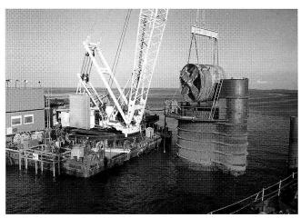
Bild 9: Bergung der Maschine offshore. (Foto: Herrenknecht AG)
