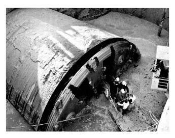
Bild 2: Einfahrt in den Zielschacht. (Foto: Herrenknecht AG)
