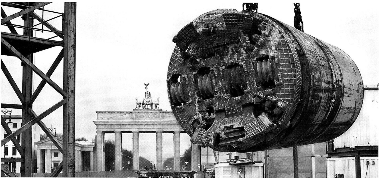
Bild 11: Umsetzen der rückziehbaren Vortriebsmaschine für die nächste Bohrung; Schneidrad mit klappbaren Kaliberwerkzeugen. (Foto: Herrenknecht AG)
