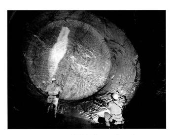
Bild 4: Ortsbrust und Schneidbild der Hartgesteinswerkzeuge (Disken). (Foto: Herrenknecht AG)
