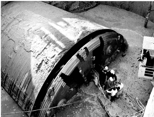
Bild 2: Einfahrt in den Zielschacht. (Foto: Herrenknecht AG)
