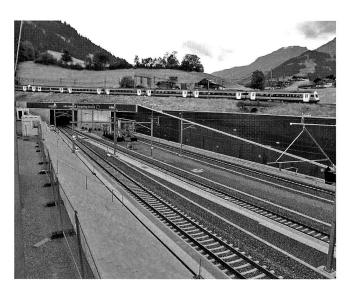
Bild 11: Nordportal des Lötschberg-Basistunnels in Frutigen, Unterquerung der BLS-Bergstrecke. (Foto: AlpTransit Gotthard AG)<sup>70</sup>
