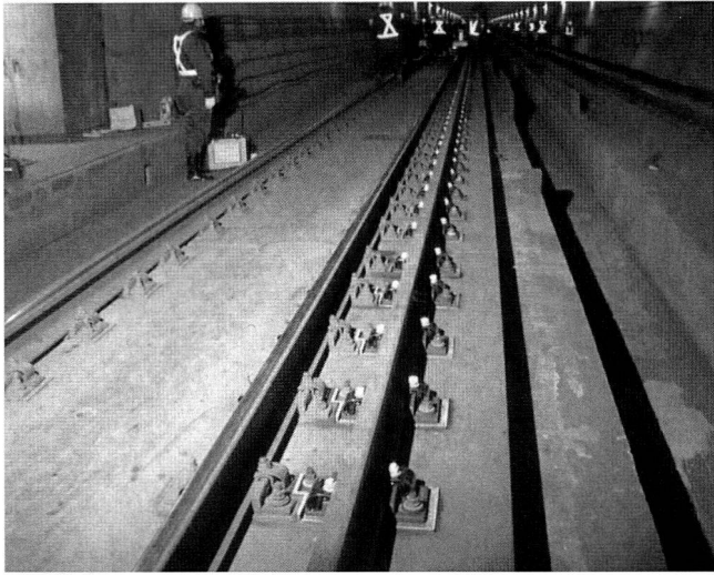
Bild 3: Die feste Fahrbahn im Tunnel für die beiden Spurweiten «Kap» und «Normal». (Foto: JRTR)
