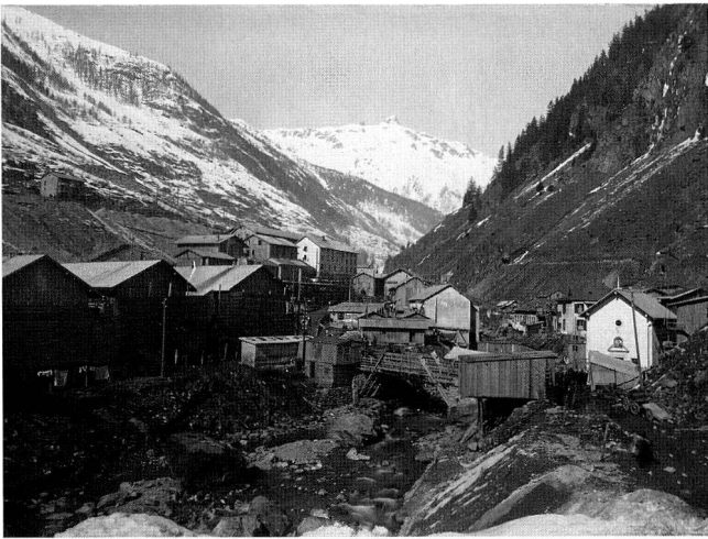
Bild 10: Holzbaracken bei der Kapelle von Goppenstein. Der Eisenbahnviadukt steht noch nicht. (Foto: BLS-Archiv, Nr. 1736, Südportal)
