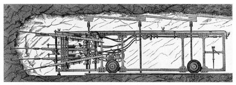
Bild 11: Vortrieb mit Bohrmaschinen von Sommeiller.
