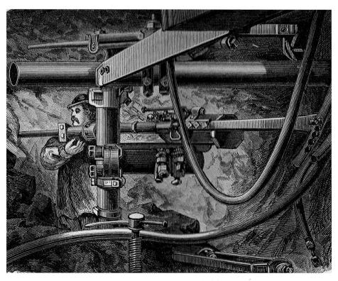
Bild 13: Burleigh-Bohrmaschine im Hoosac-Tunnel.
