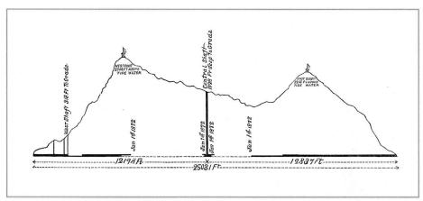
Bild 9: Profil des Hoosac-Tunnels.
