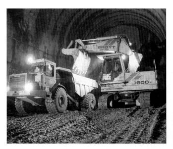
Bild 20: Laden des Haufwerks auf Muldenkipper.
