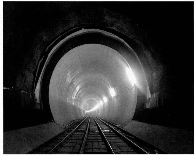
Bild 3: Einspurige Tunnelröhre des Gotthardbasistunnels in der Nähe des Südportals in Bodio. (Foto: AlpTransit Gotthard AG)
