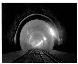
Bild 3: Einspurige Tunnelröhre des Gotthardbasistunnels in der Nähe des Südportals in Bodio. (Foto: AlpTransit Gotthard AG)
