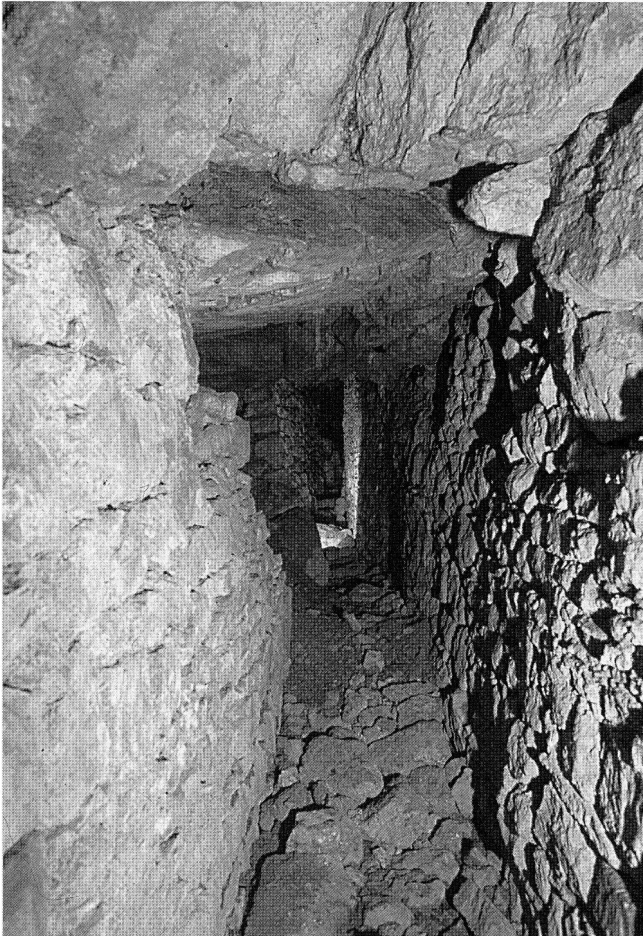
Bild 15: Tiergartentunnel von Blankenheim/Ahr (Deutschland). Tunnelinneres. (Foto: Klaus Grewe)
