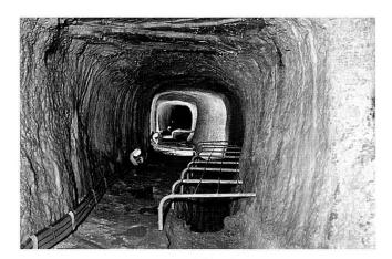
Bild 3: Eupalinos-Tunnel auf Samos. Blick in den Tunnel mit seitlichem Graben für die Wasserleitung. (Foto: Klaus Grewe)
