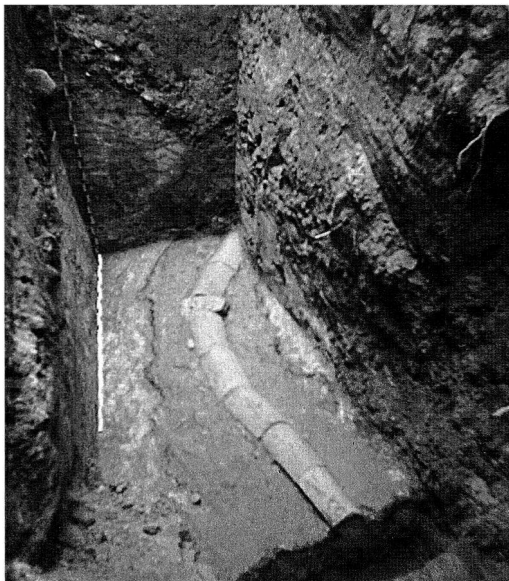
Bild 11: Drovers-Berg-Tunnel bei Düren (Deutschland). Die Wasserleitung knickt aus dem Hangverlauf in den Tunnel ab. (Foto: Klaus Grewe)
