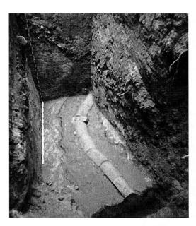
Bild 11: Drover-Berg-Tunnel bei Düren (Deutschland). Die Wasserleitung knickt aus dem Hangverlauf in den Tunnel ab. (Foto: Klaus Grewe)
