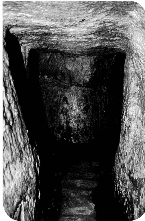
Bild 1: Hiskia-Tunnel von Jerusalem. Blick auf den Blindstollen in einer Korrekturstelle des Vortriebs. Diese Blindstrecken sind ein unwiderlegbarer Beweis für Planung und Trassierung. (Foto: Klaus Grewe)
