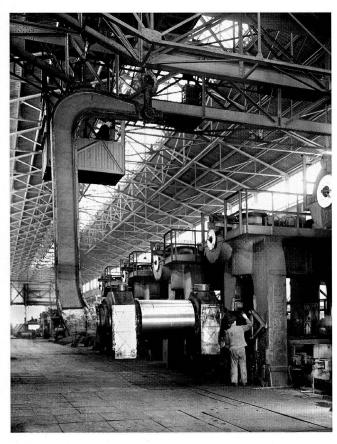
Wechsel der Stützenwalzen der 6-gerüstigen Fertigstrasse, um 1937.
