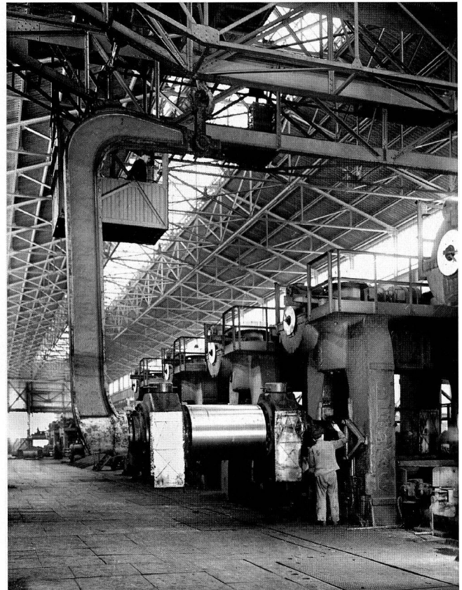
Wechsel der Stützenwalzen der 6-gerüstigen Fertigstrasse, um 1937.
