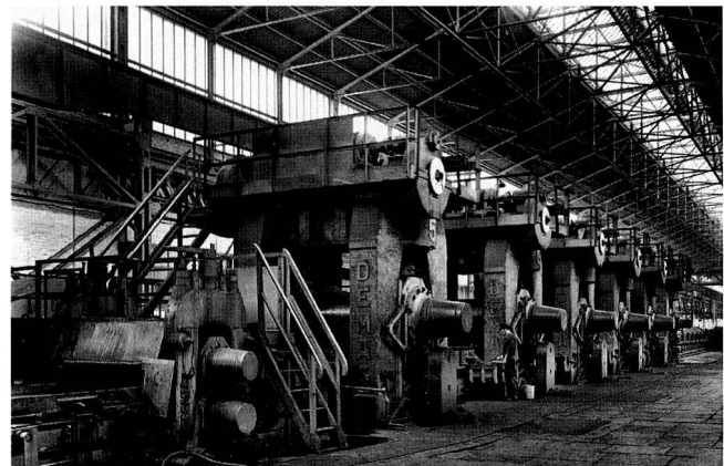
Zunderbrecher und 6-gerüstige Fertigstrasse, um 1937.
