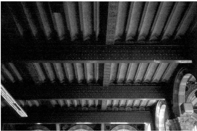
Kappendecke des Wartsaals der Centraal-Station in Amsterdam, 1881–89.
